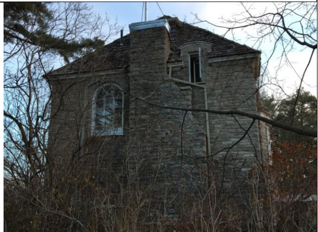
Photo 6 : Façade latérale droite, novembre 2019 Source : Ville de Gatineau
