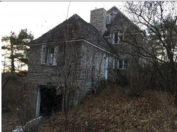
Photo 5 : Façade latérale gauche, novembre 2019 Source : Ville de Gatineau
